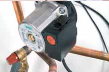
Corpo pompa in alluminio e chiocciola in ghisa (no materiale plastico) Body pump in aluminium and cast iron top (no plastic material) Corps de la pompe en aluminium et partie superieure en fonte (aucun materiel en plastique) Körper - pumpe aus aluminium und rolle aus guss (keine plastik teile)
